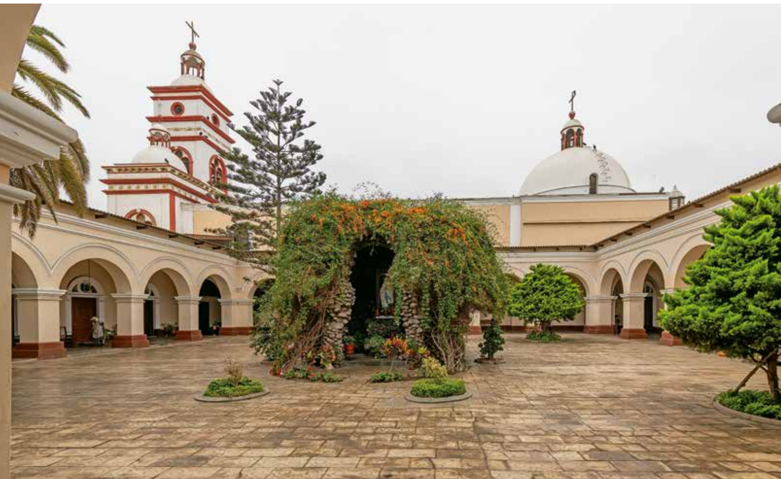
▲ Fig. 46. Monasterio de Santa Clara la Real de Trujillo. Vista del claustro-
