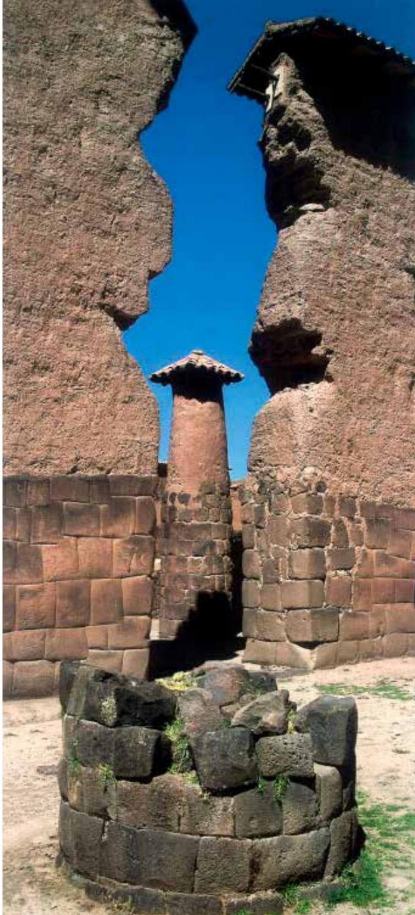
6. Vano de acceso en el muro central del Templo de Wiracocha en Raqchi. La base de piedra labrada tiene 3 metros de altura y el coronamiento de adobe supera los 8 metros. Se observan los restos de las columnas cilíndricas en las que se apoyaba la cubierta.
