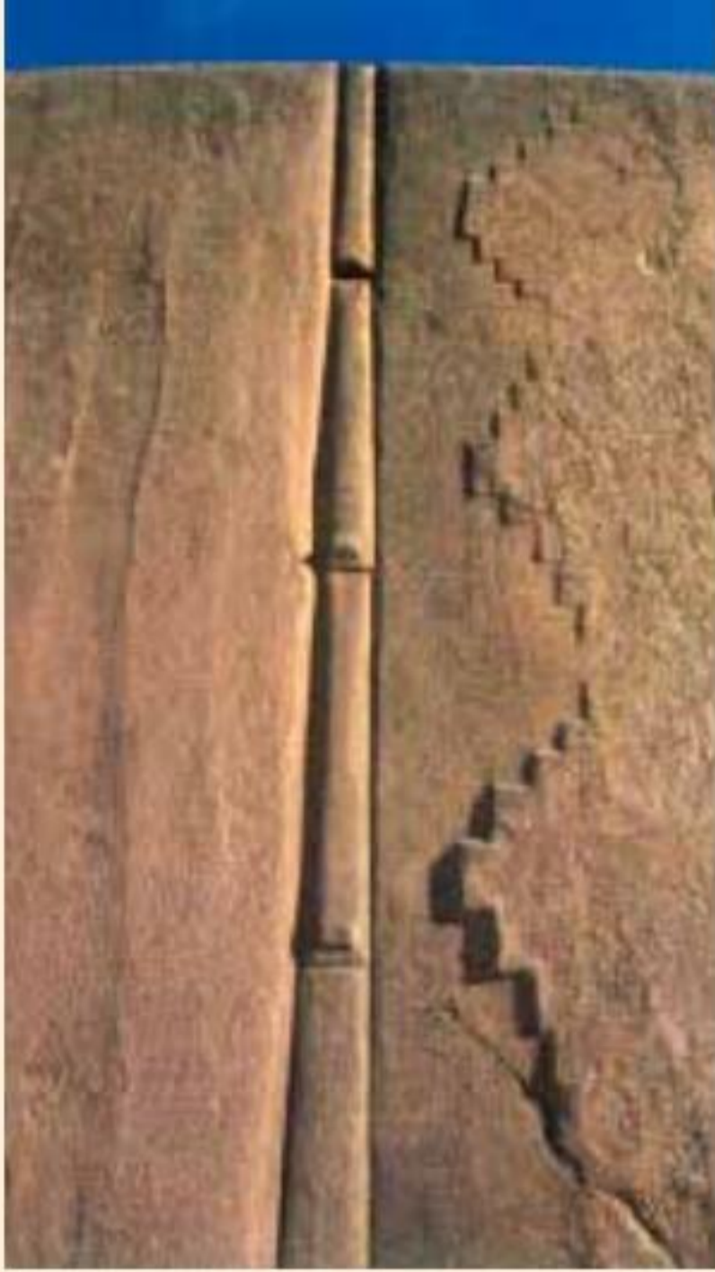
58. Detalle de los monolitos separados por listeles de piedras alargadas. La ornamentación en relieve muestra una secuencia de motivos escalonados. Templo del Sol, Santuario de Ollantaytambo .
