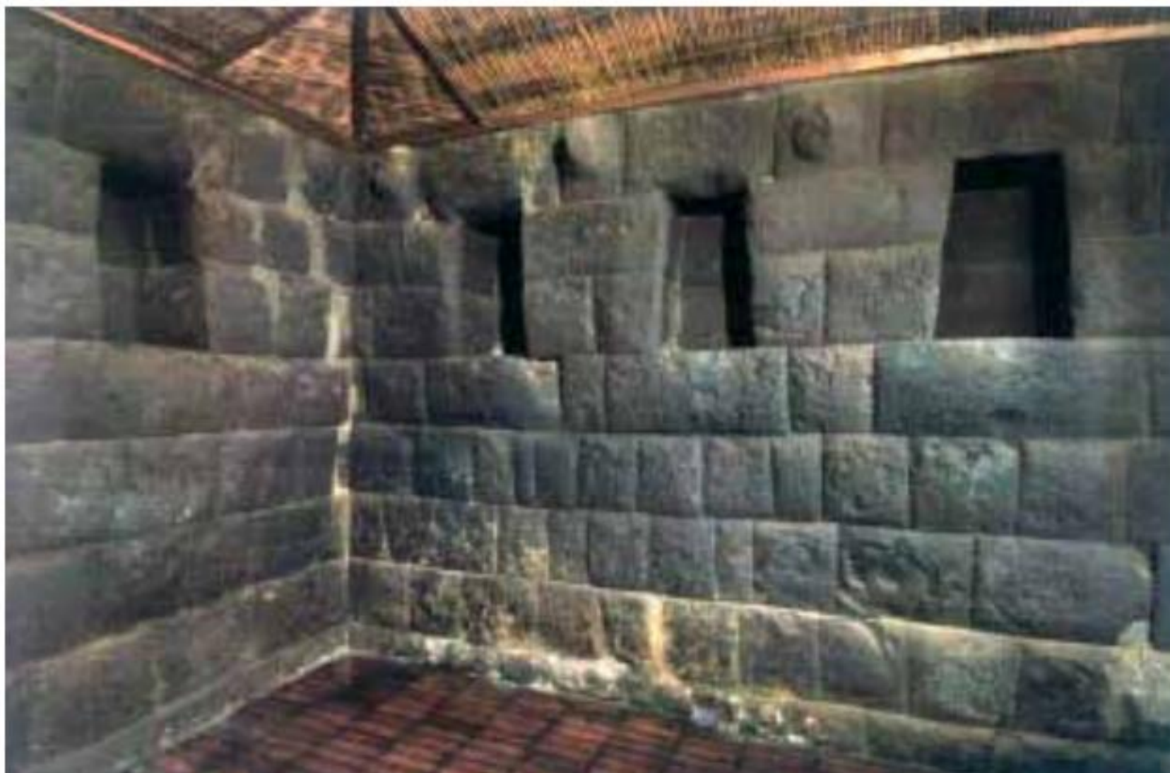
72. Interior del recinto inca de la hacienda San Agustín del Callo, en las inmediaciones del Parque Nacional de Cotopaxi, Ecuador. Nótese la distribución de nichos trapezoidales y clavos cilíndricos salientes, propios de la arquitectura inca.
