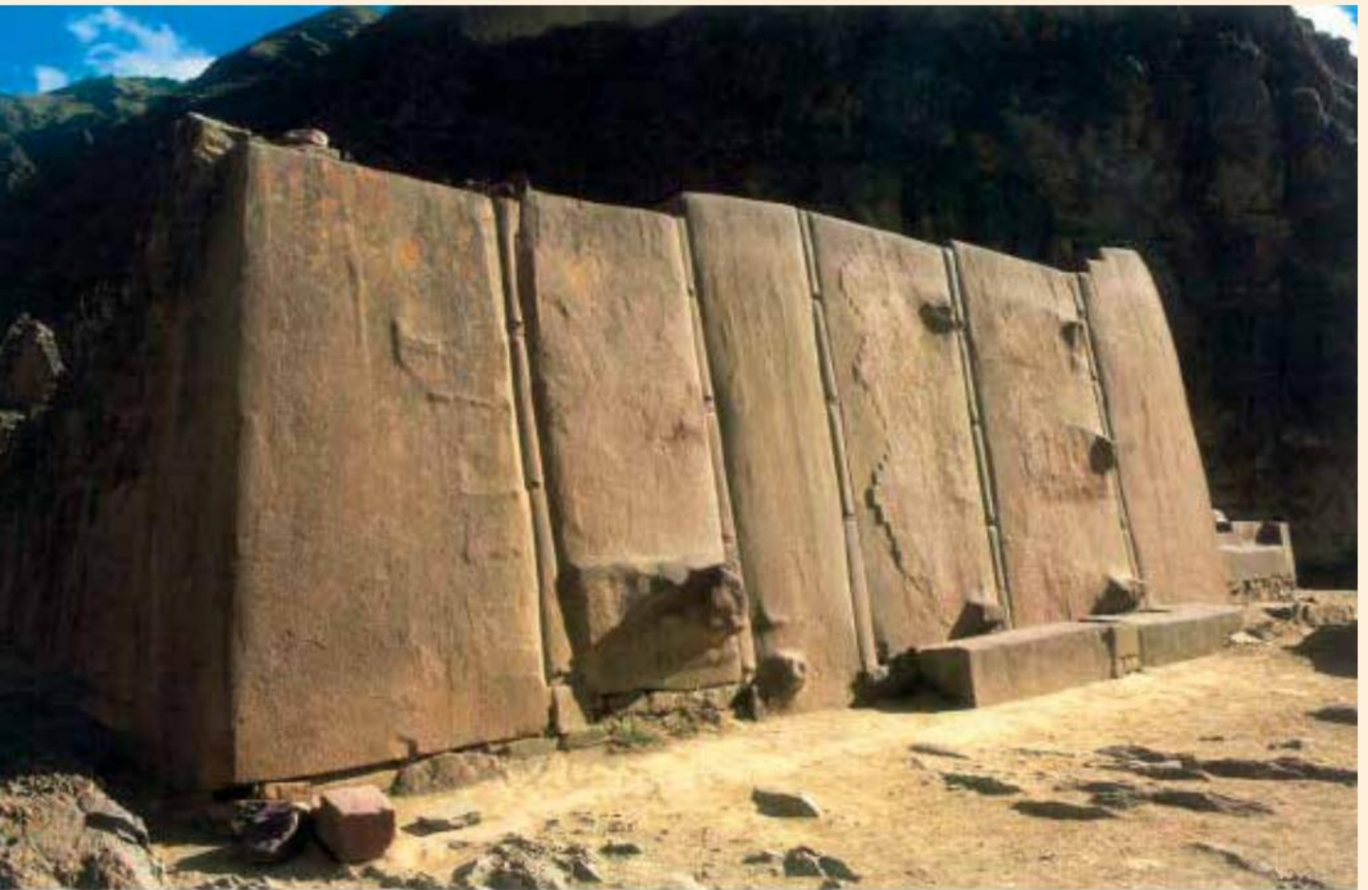
56. Muro de los Seis Monolitos unidos con listeles verticales. Lado sureste del Templo del Sol en la cumbre de la colina. Santuario de Ollantaytambo .
