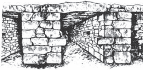
GALERIAS. - Aspecto de las Galerías que según el Dr. Tello recorren el interior de los Templos en Chavín de Huántar.
